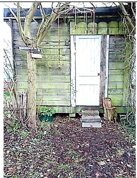
Nouvelle porte à notre abri (merci Yannick)
