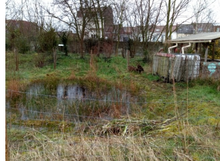
Réparation de la fuite de la cuve
