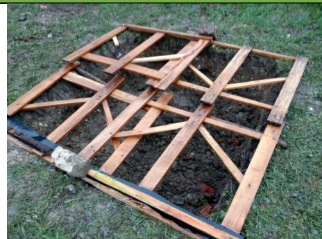
Creusement du trou de la tour
